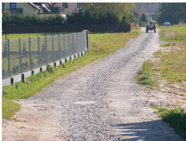
Wybudowana kanalizacja sanitarna na osiedlu Słocina – Leśniczówka w Rzeszowie
