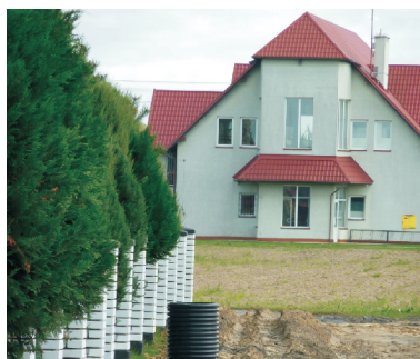
Budowana kanalizacja sanitarna w Kuryłówce
