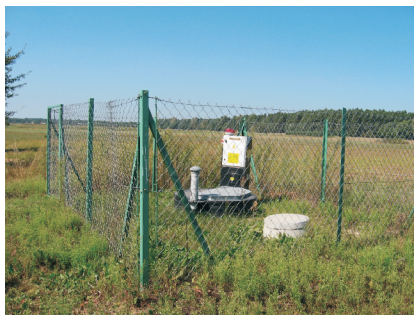
Jedna z wybudowanych pompowni ścieków w Dąbrowicy
