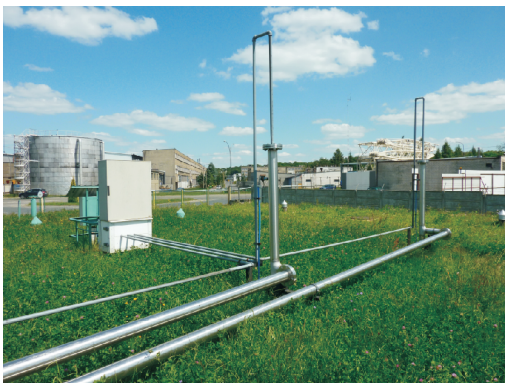
Wybudowana czwarta komora osadnika wstępnego w ramach modernizacji SUW
