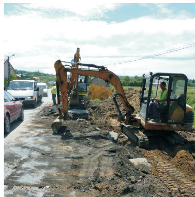
Budowa kanalizacji sanitarnej wzdłuż ul. Polnej
