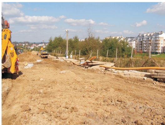
Budowa kanalizacji sanitarnej w rejonie ulic Bł. Karoliny, Pańskiej i Ustrzyckiej
