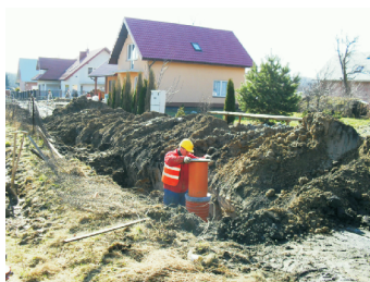
Budowa głównego ciągu kanalizacji przy ulicy Wyszyńskiego.
