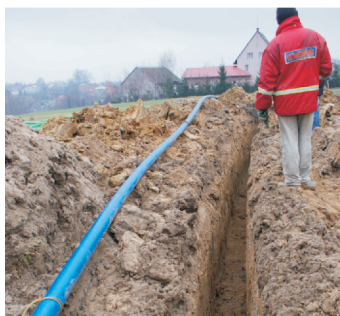
Prace przy budowie wodociągu na ulicy Borki Chechelskie.
